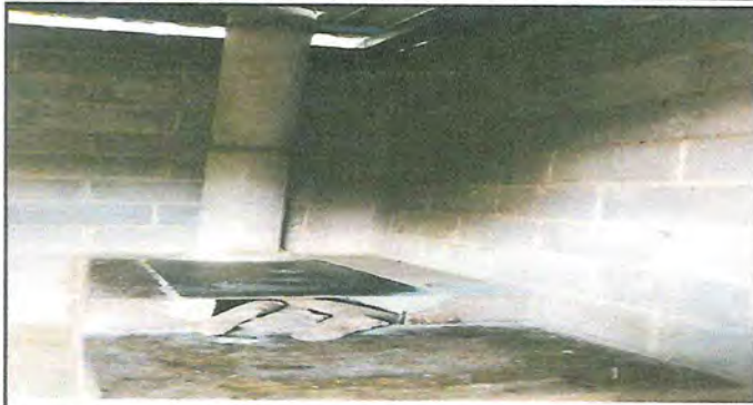
Foto 1: Plancha de 3 hornillas ya sustituidas.
