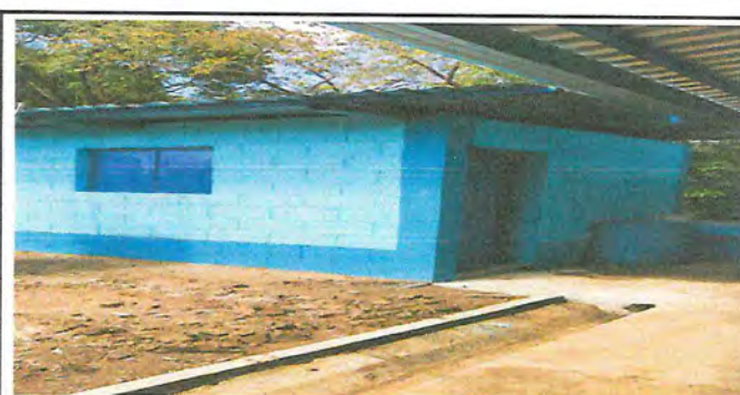
Foto 4: Cocina ya con ventana y puerta nueva.
