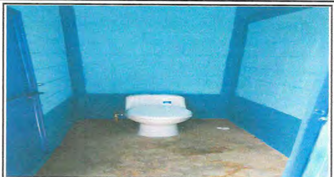
Foto 2: Sanitarios ya sustituidos.
