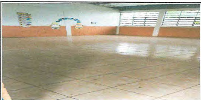
Foto 5: Sustitucion de piso ya finalizado
