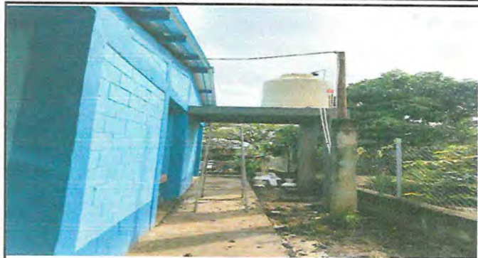
Foto 1: Base de tinaco terminada.
