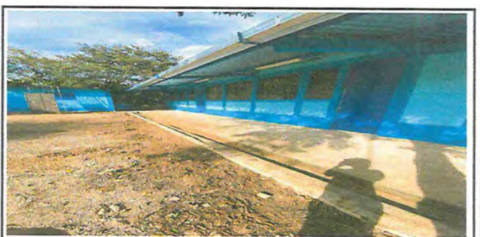
Foto 6: Tuberia de aguas pluviales terminada.
